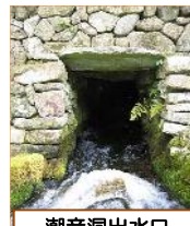
潮音洞出水口
